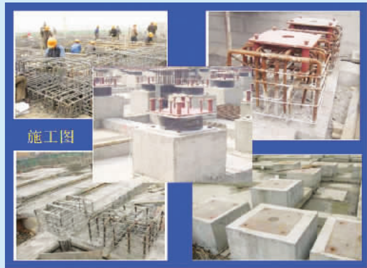
减隔震建筑施工现场图
